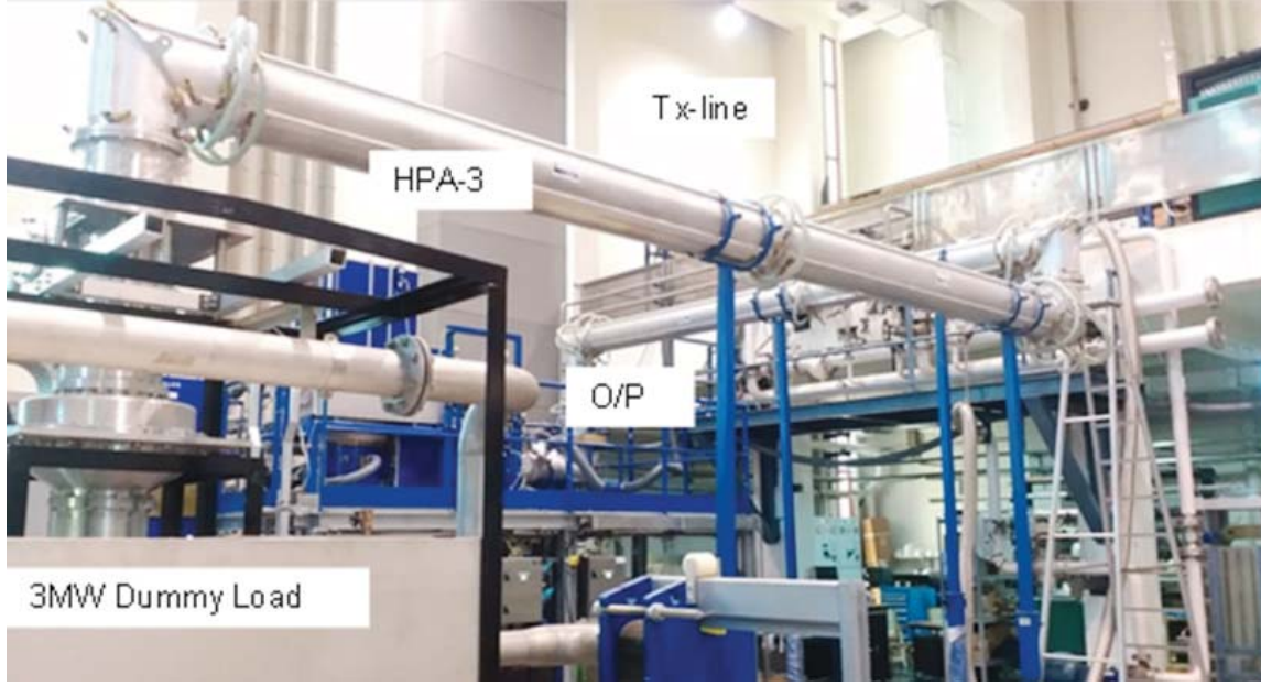
चित्र B.2.10 फैक्ट्री परीक्षणों से गुजर रही टेट्रोड आधारित प्रणाली डमी लोड सहित
